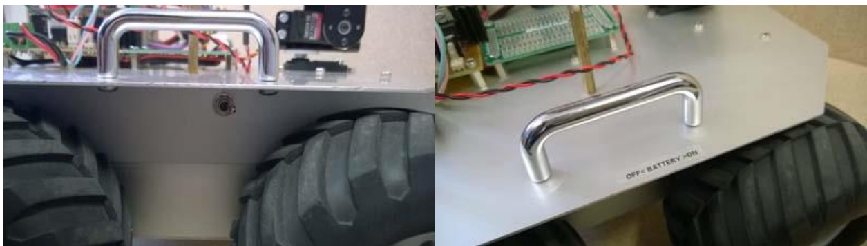
Particolare dell'interruttore generale batteria, installato sotto la copertura, con etichetta Dymo trasparente posta al di sopra
